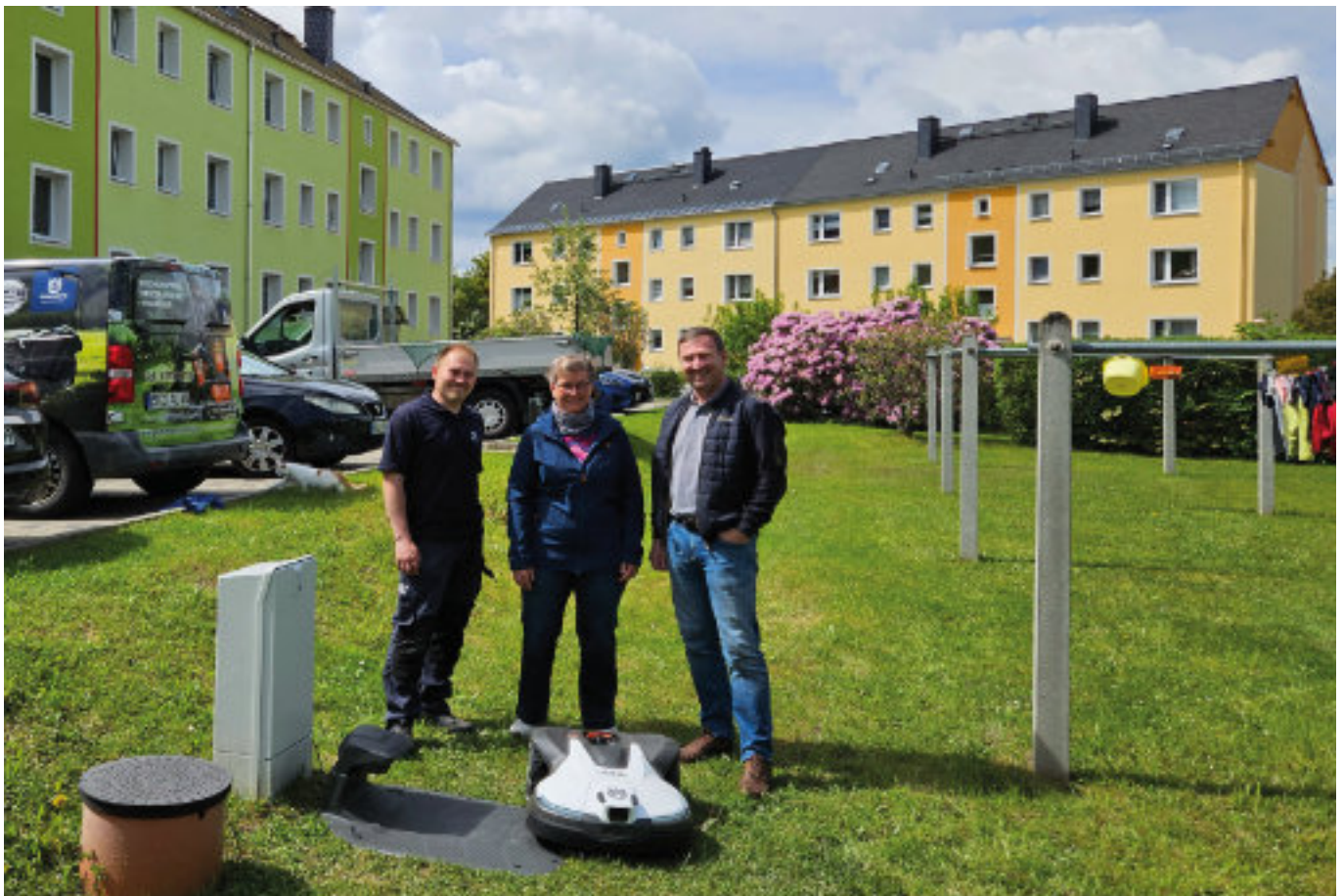
V. l.: Herr Eric Theile (Ausstatter Fa. Uhlig Burkhardtsdorf), Frau Katja Tröger (Fa. Piepenbrock) und Tim Schneider bei der Inbetriebnahme.
