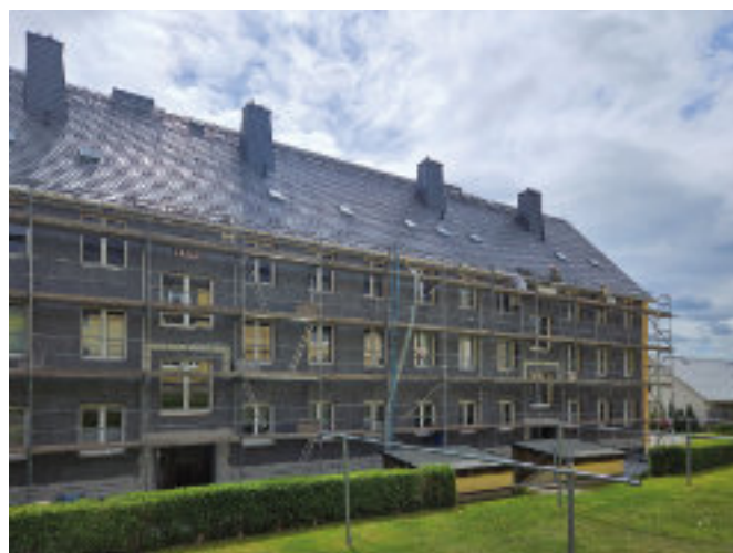
Die Wärmedämmung wird durch die Fa. Werner aufgebracht.
