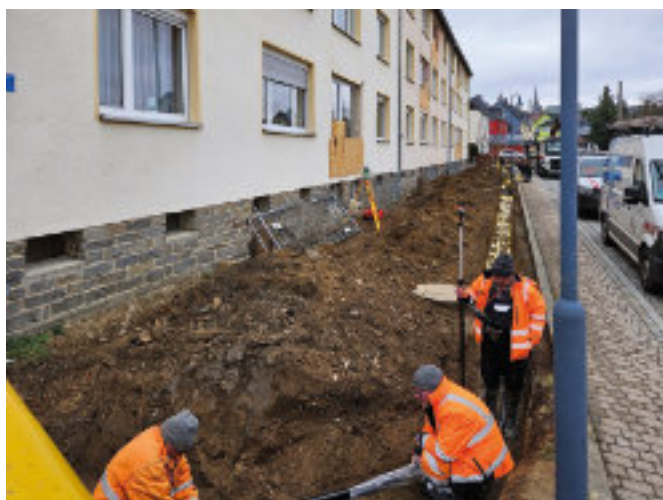
Umverlegung der Elektroleitung für die Balkonfundamente.
